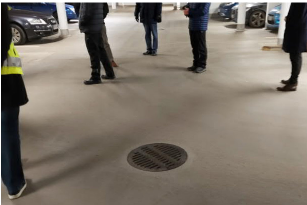
Kuva 4. Pysäköintihallin lattiakaivo.
