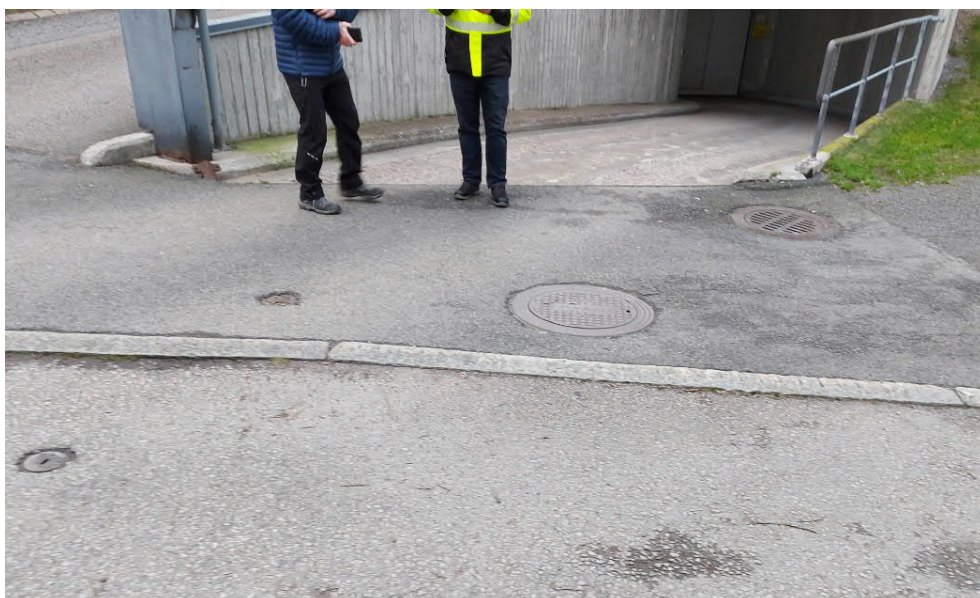
Kuva 2. Valokuva pysäköintihallin edustalta. Hulevesikaivo kuvan oikeassa ylälaidassa.
